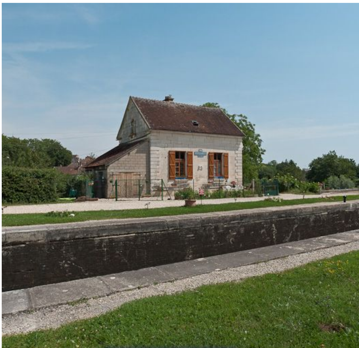
Vue de la maison éclusière.
