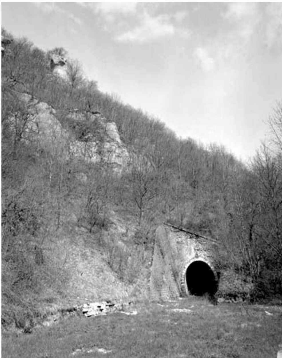
Bonnevaux-le-Prieuré : le tunnel.
