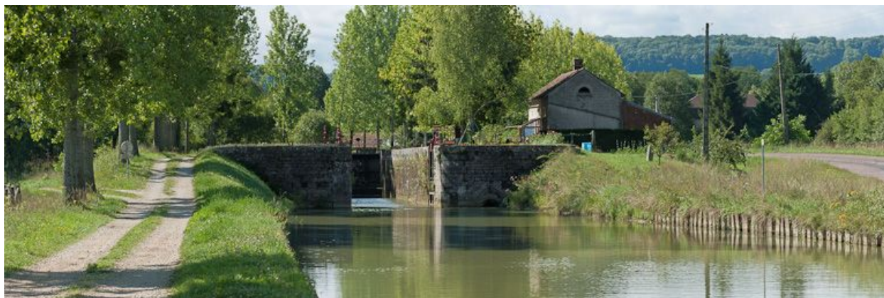
Vue du site d'écluse depuis l'aval.
