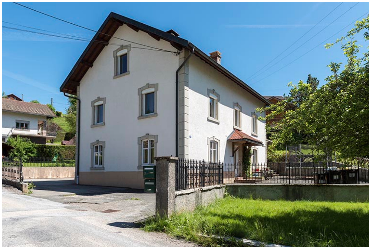
Façades antérieure et latérale gauche.
