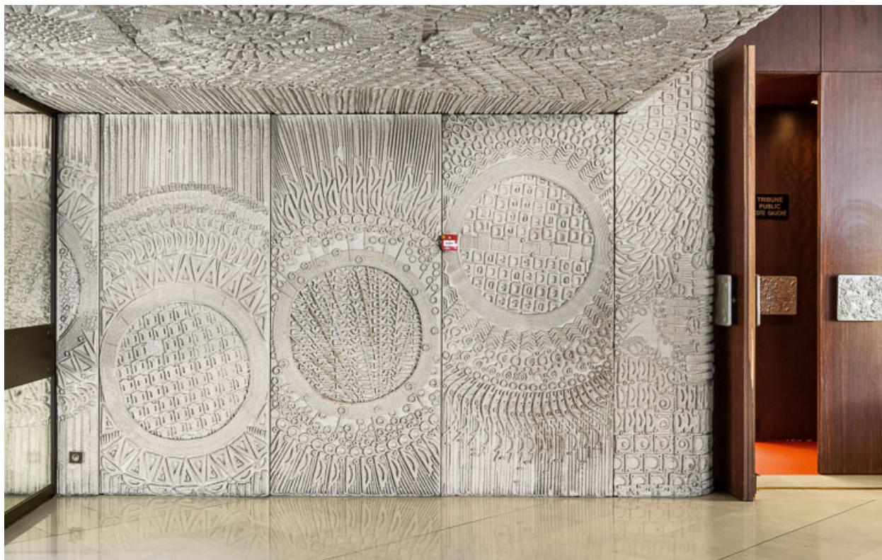
Hall d'accueil : panneaux moulés à l'entrée.
