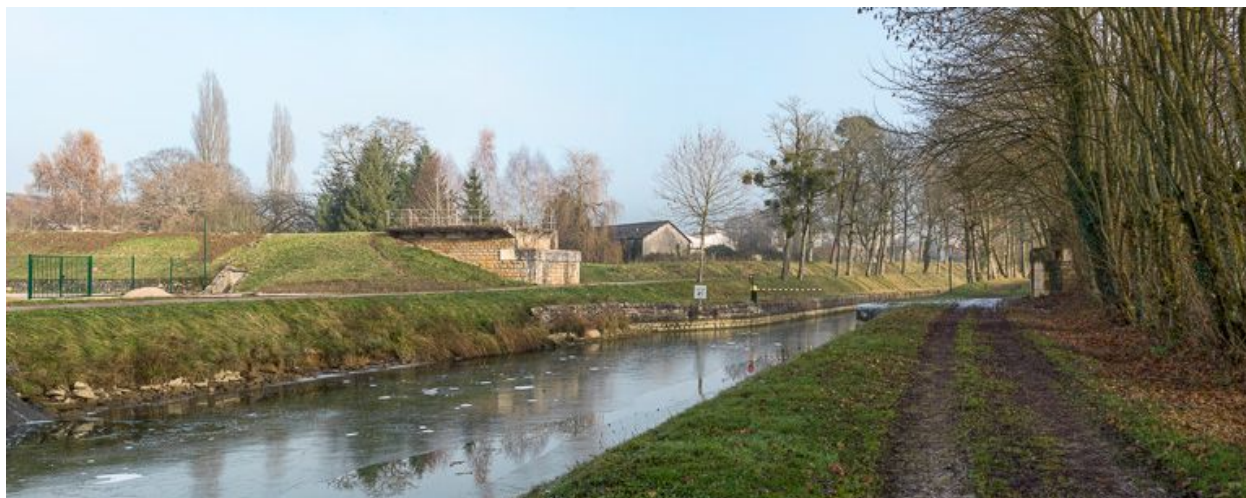
Vue d'aval des culées.
