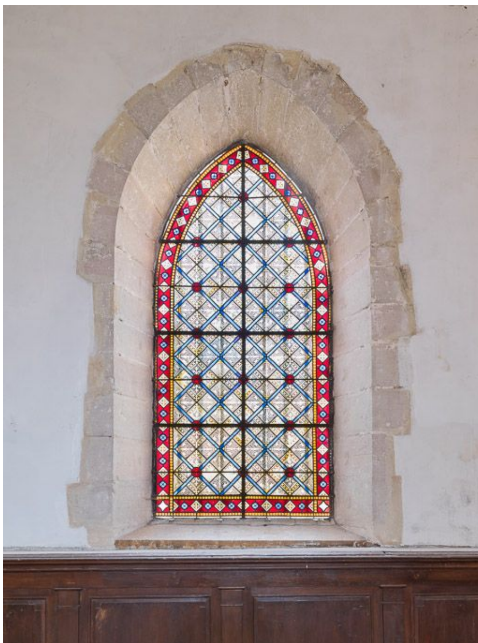
Vue d'ensemble, verrière du chœur.
