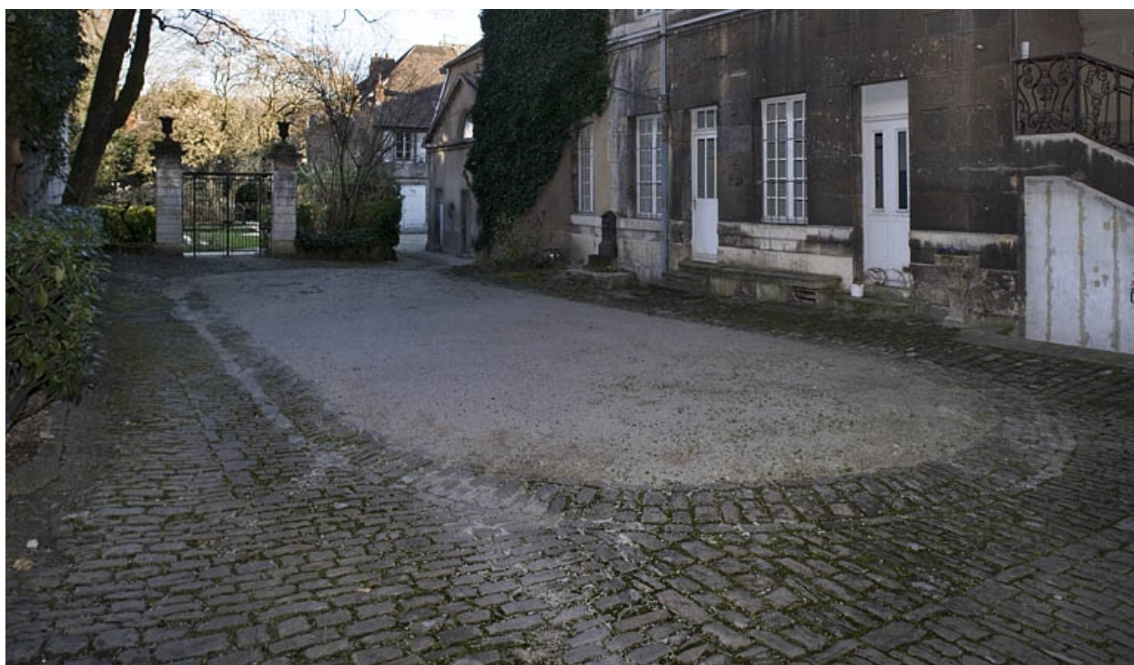
Vue d'ensemble du pavage de la cour.
