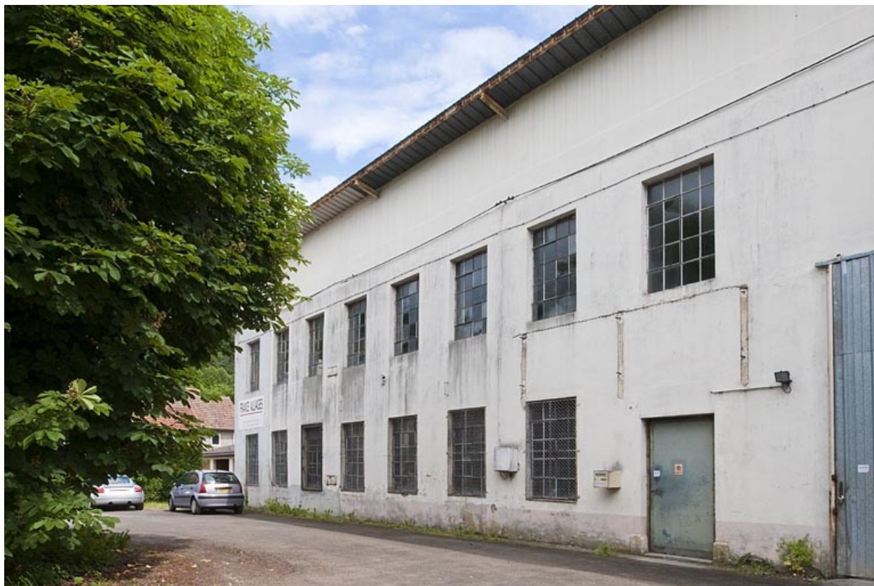
Façade nord de l'atelier de fabrication.
