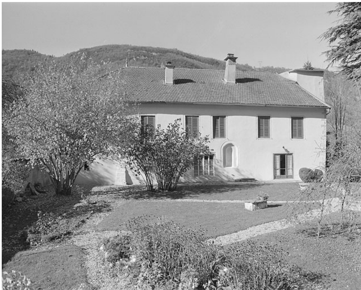
Façade principale, vue de trois quarts.
