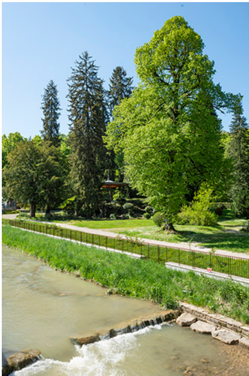
Berges de la Furieuse réaménagées en 2019.
