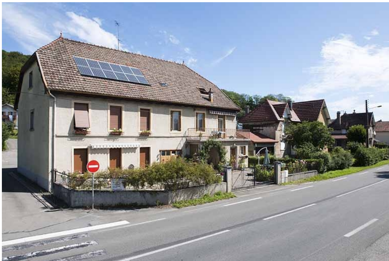
Vue d'ensemble depuis la route.
