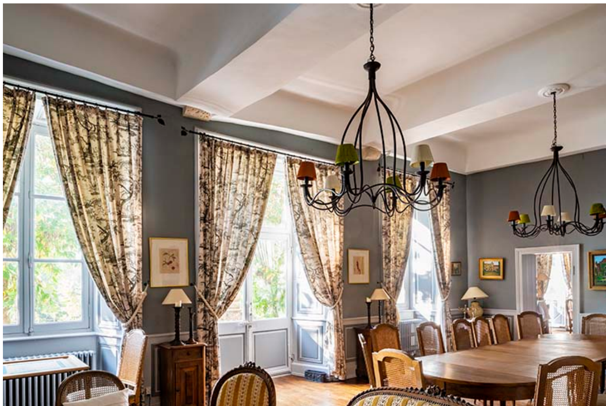
Rez-de-chaussée du corps principal, poutres et corbeaux.
