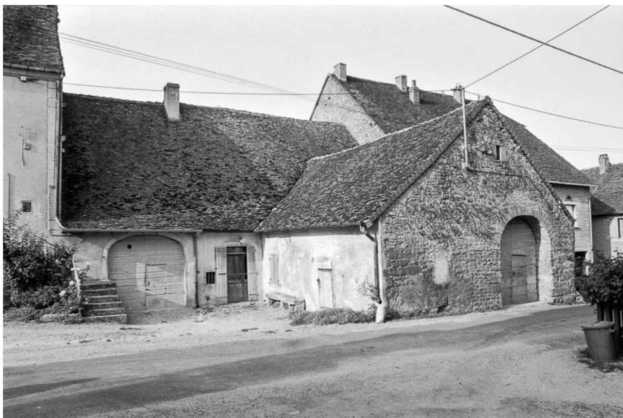
Ferme cadastrée AD 327 : façades antérieures.
