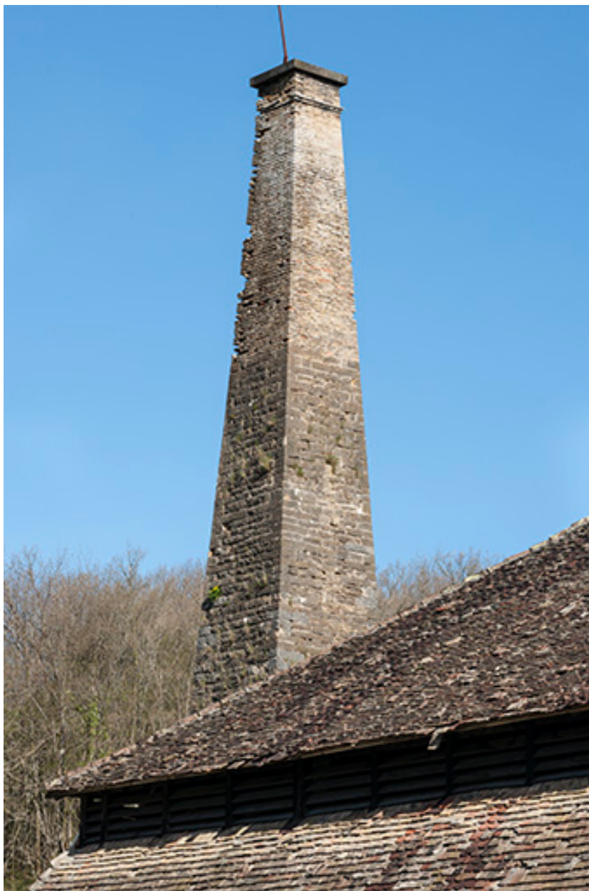
La cheminée de la chaufferie.
