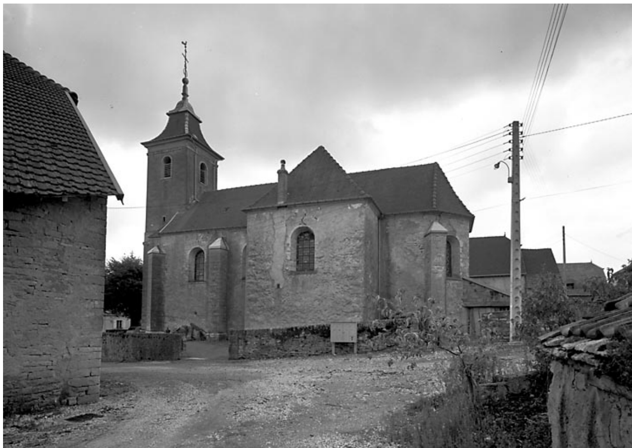
Façade latérale droite.
