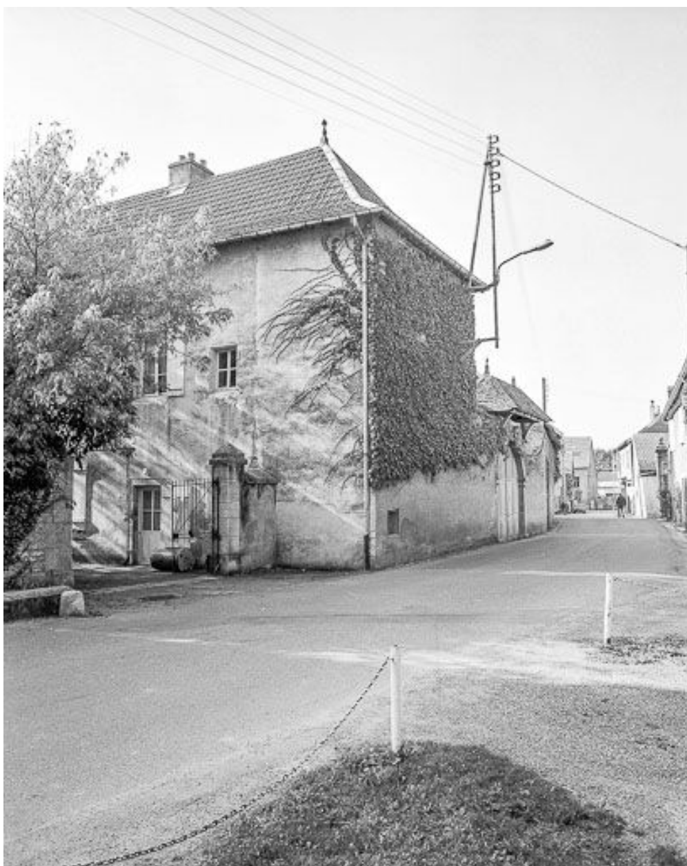
Ferme située rue du Canal.
