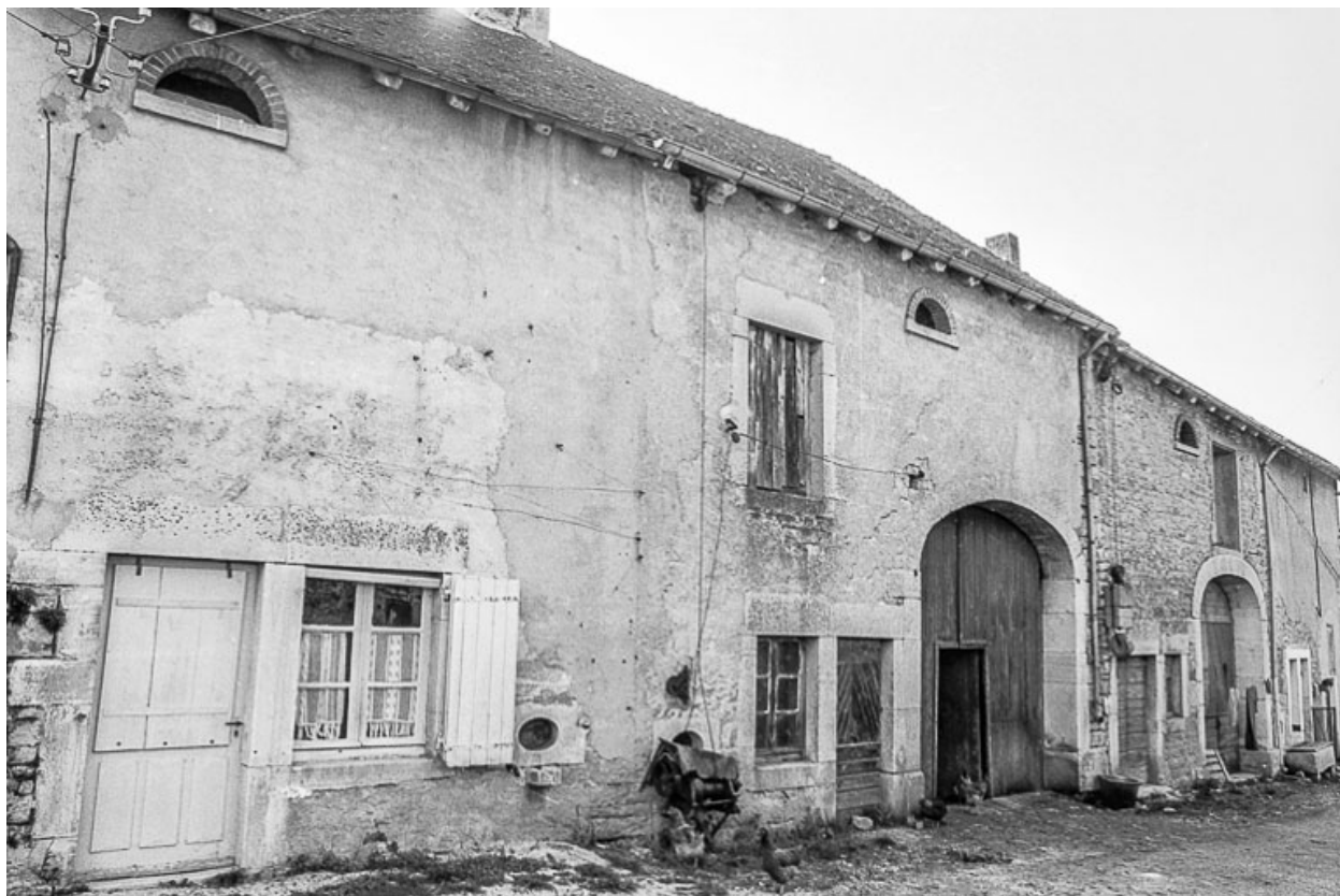
Ferme cadastrée D2 292 : façade antérieure.
