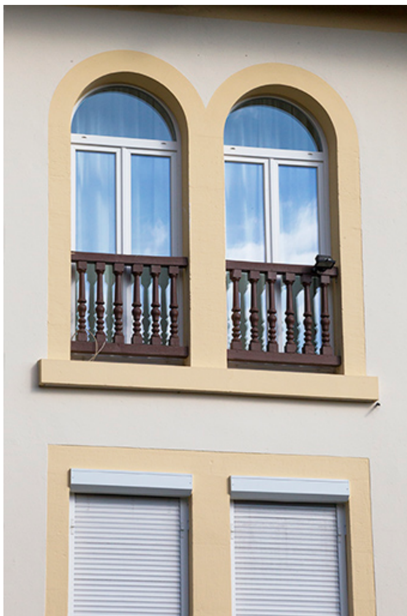
Logement patronal, façade méridionale : fenêtres.
