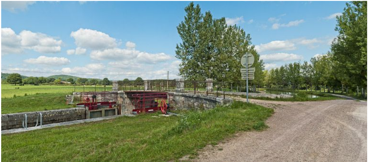
Vue du pont depuis l'amont.
