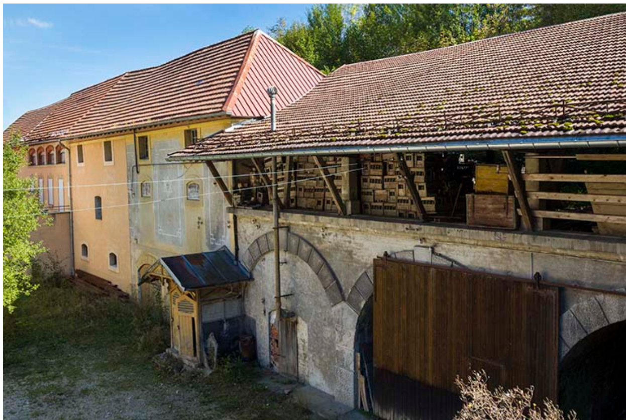
Entrepôt industriel (extrémité occidentale) et magasin industriel.
