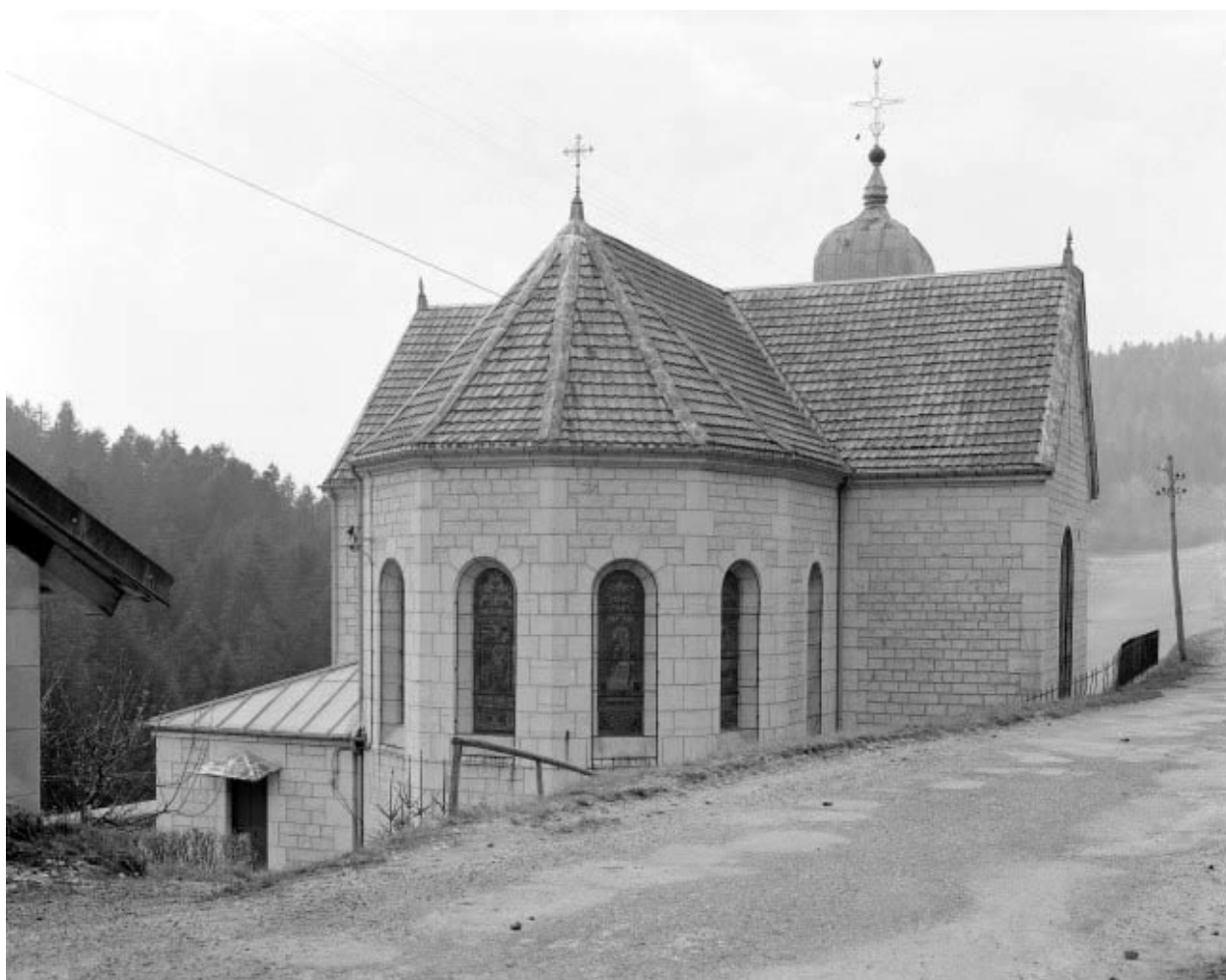
Extérieur : façade postérieure.
