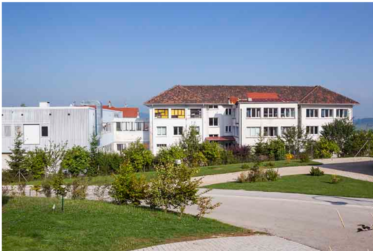
Ateliers de 1952 et 1970-1971 : façade postérieure.
