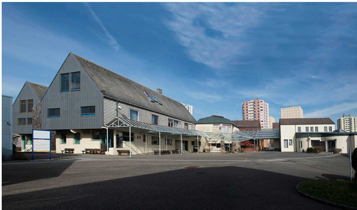
La place vue de l'ouest.
