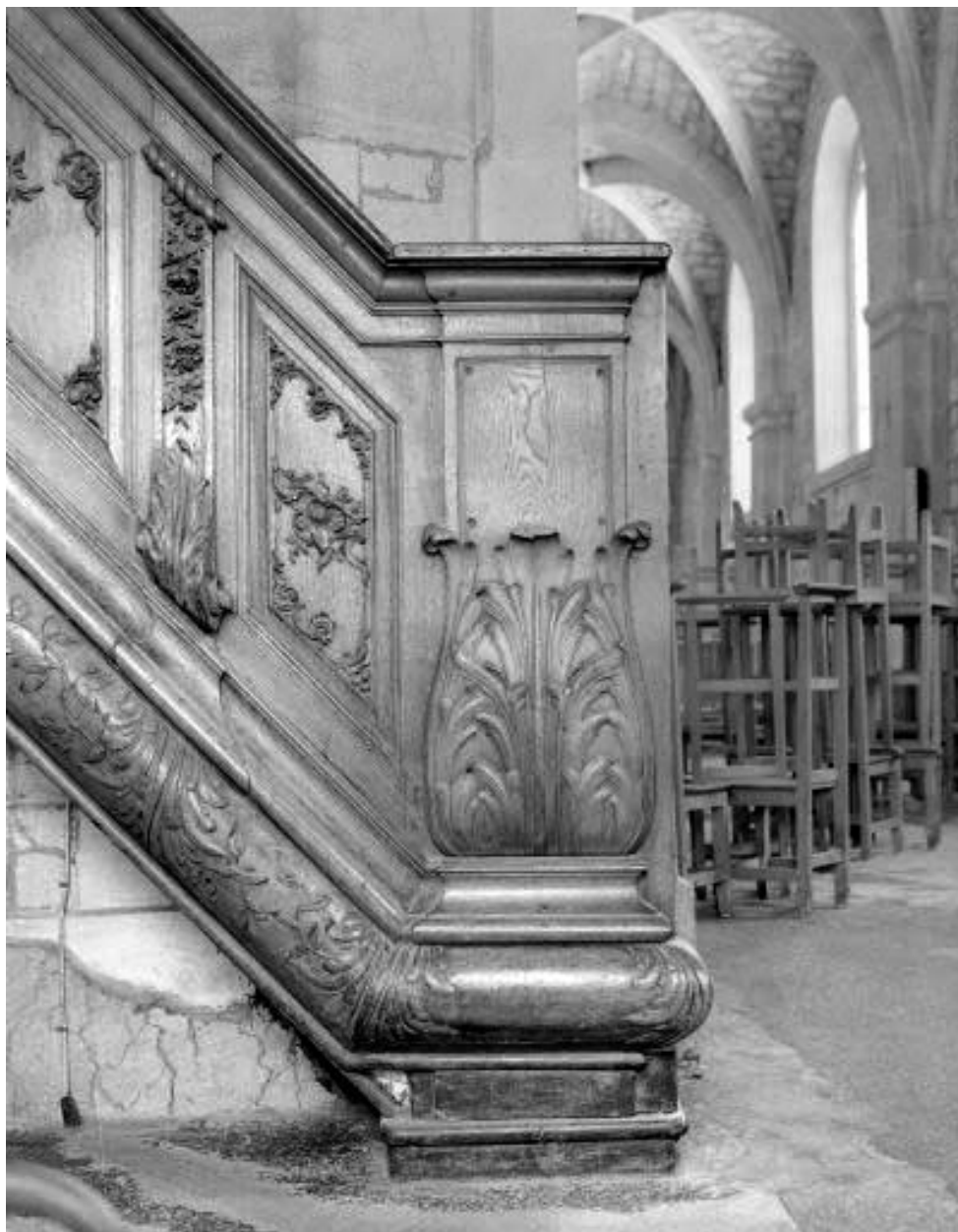
Détail : le départ de la rampe.
