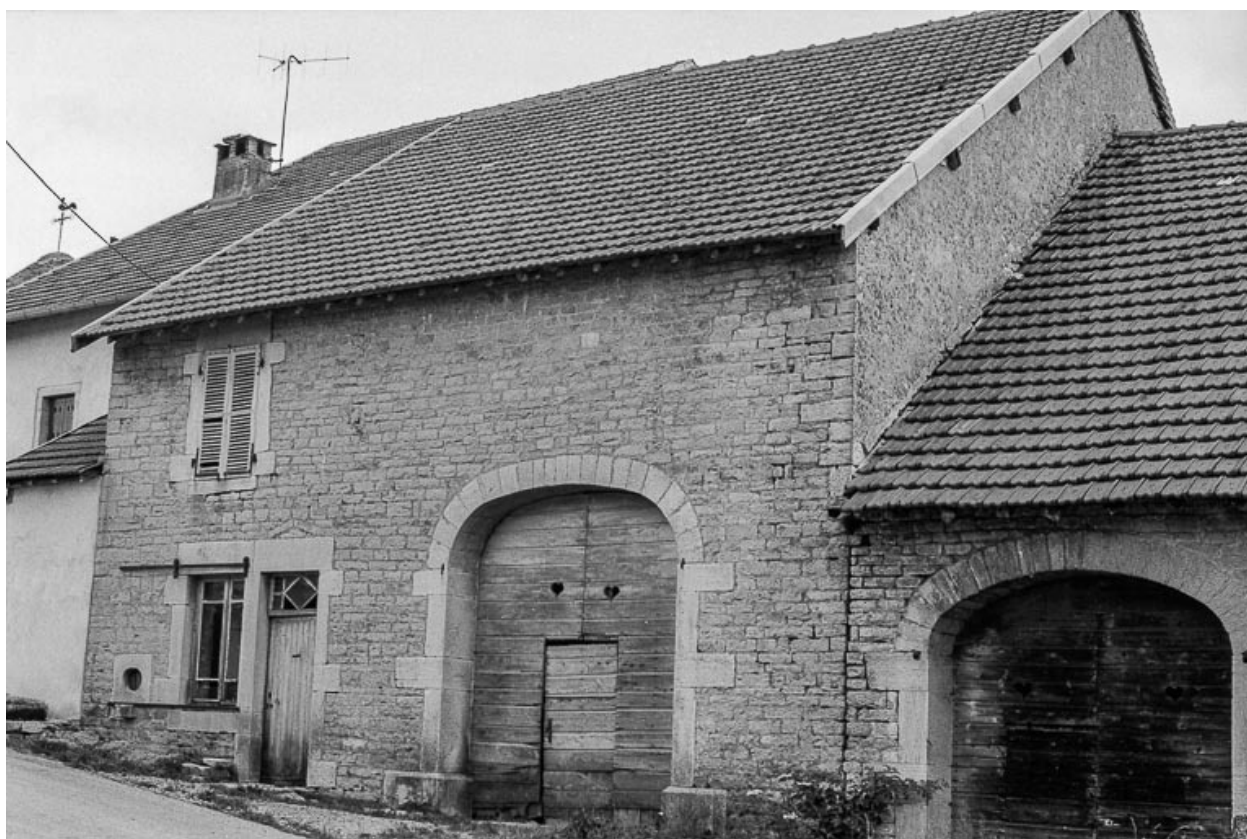
Ferme cadastrée B2 124 (droite) : façade antérieure.
