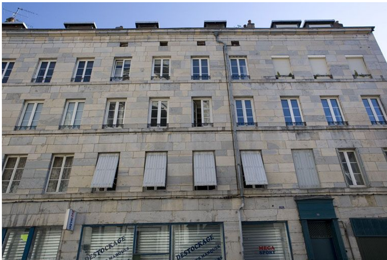
Vue d'ensemble de face depuis la rue.
