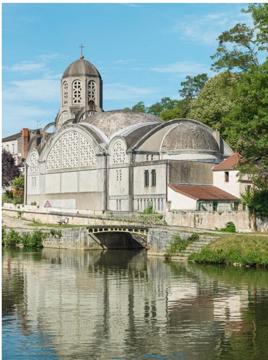
Vue d'ensemble depuis le canal du Nivernais.
