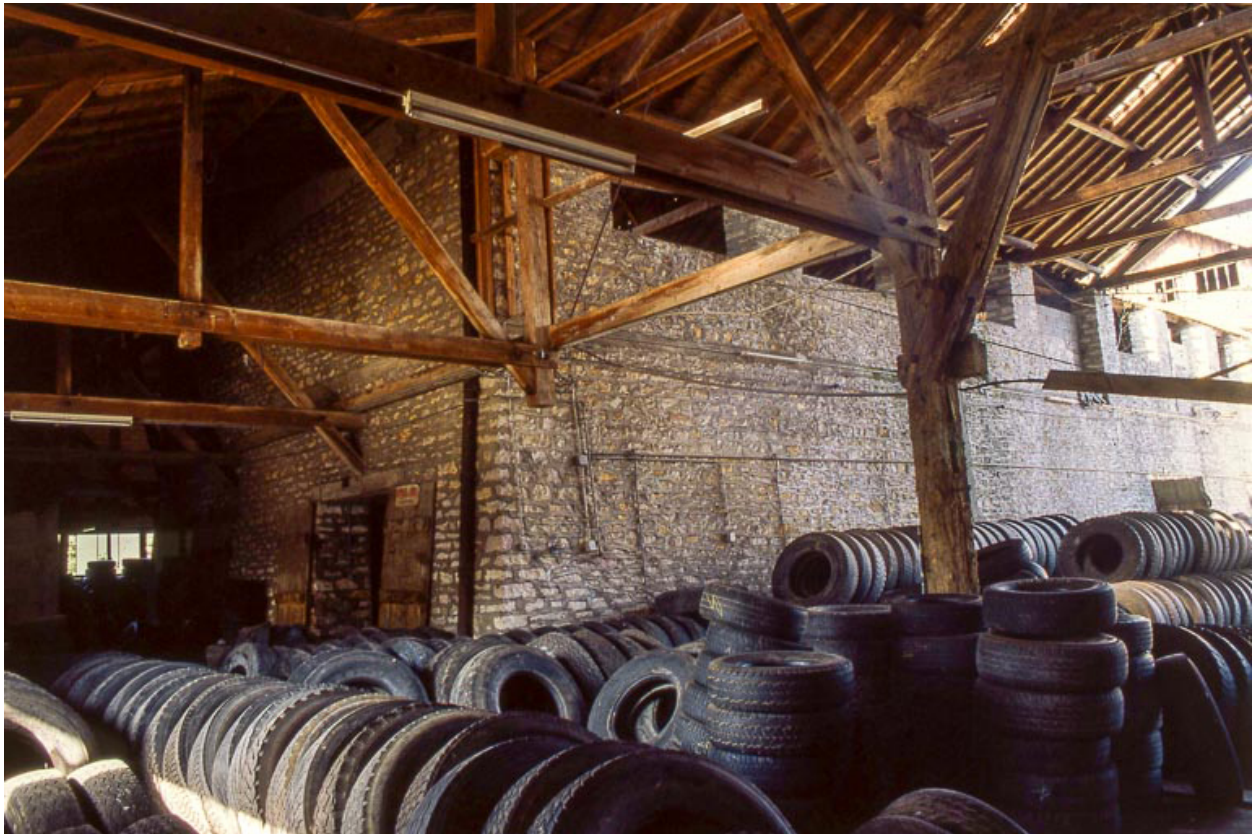
Charpente du quai et magasin industriel.
