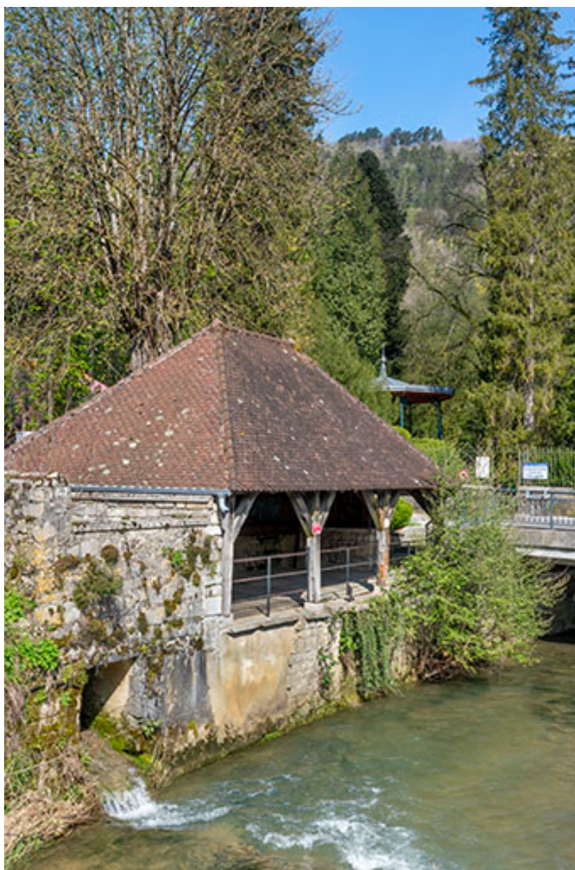
Vue depuis le sud-est.
