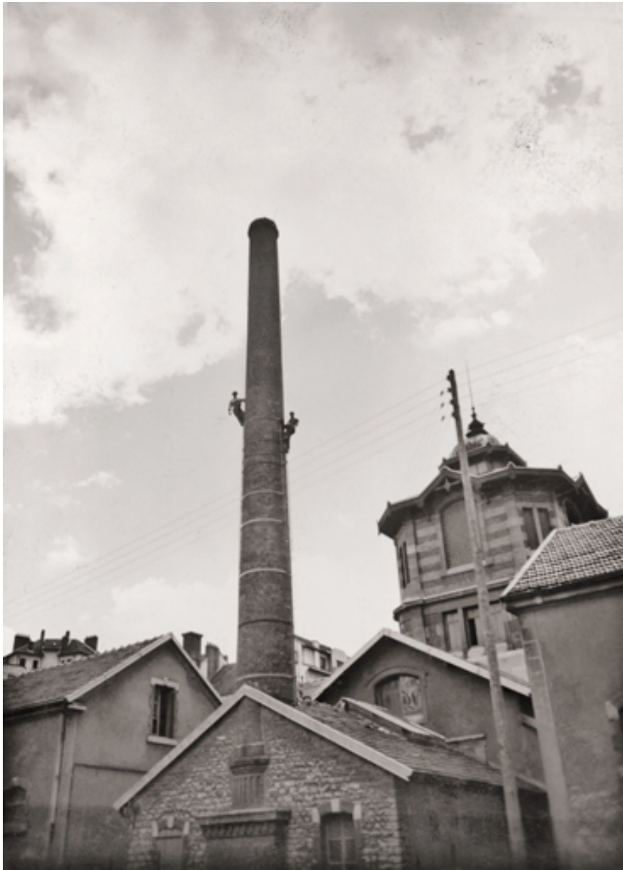
Cheminée de la chaufferie (vers 1950).
