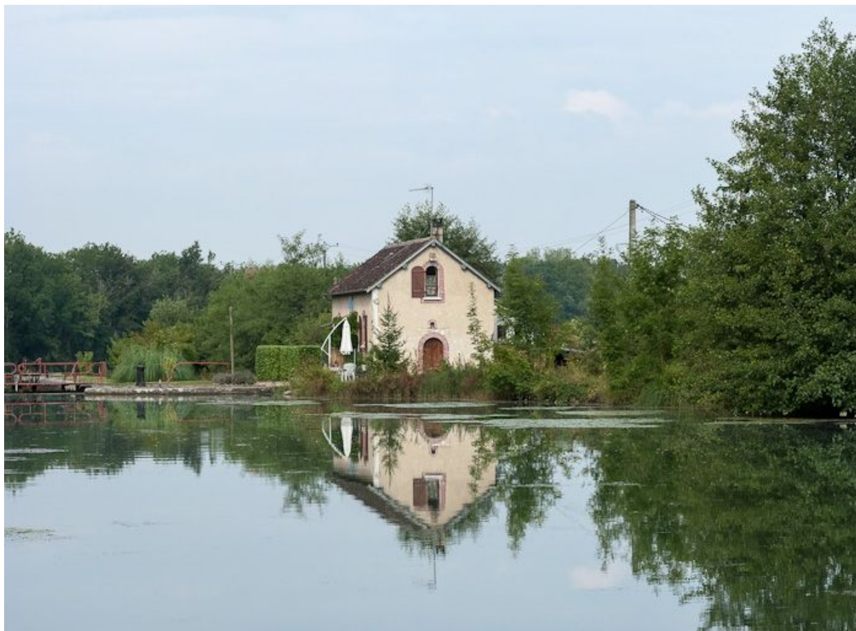
Maison éclusière dans son site.
