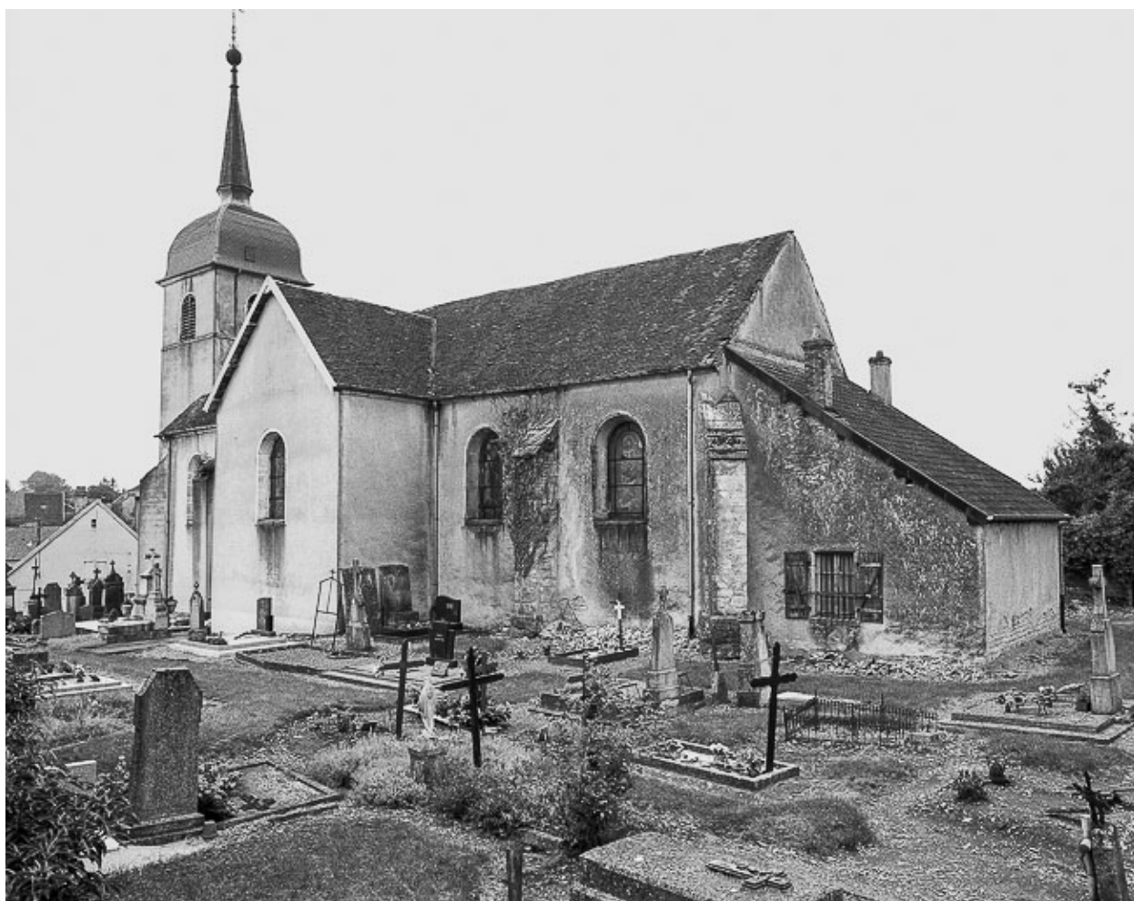
Façade latérale droite, chevet et sacristie.
