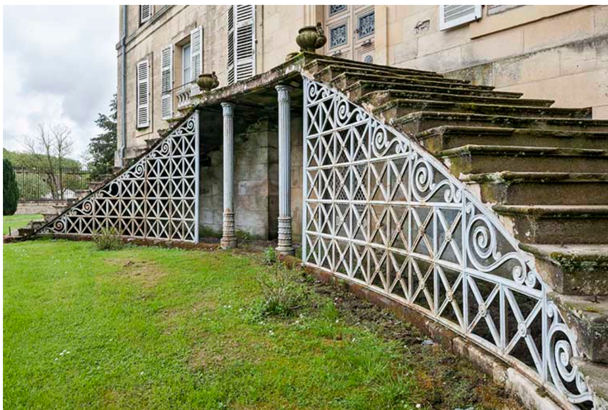
L'escalier double, façade nord.
