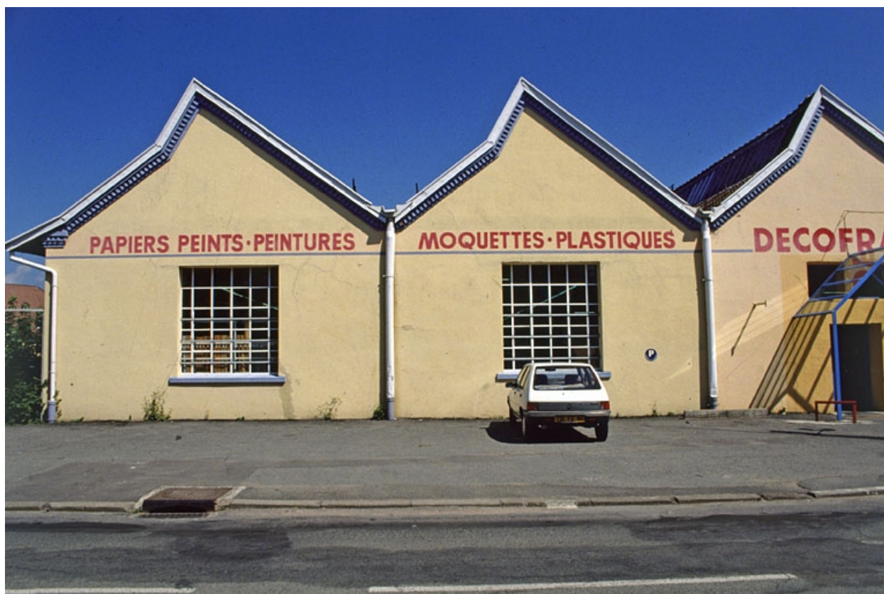
Pignons ouest de l'atelier de fabrication.
