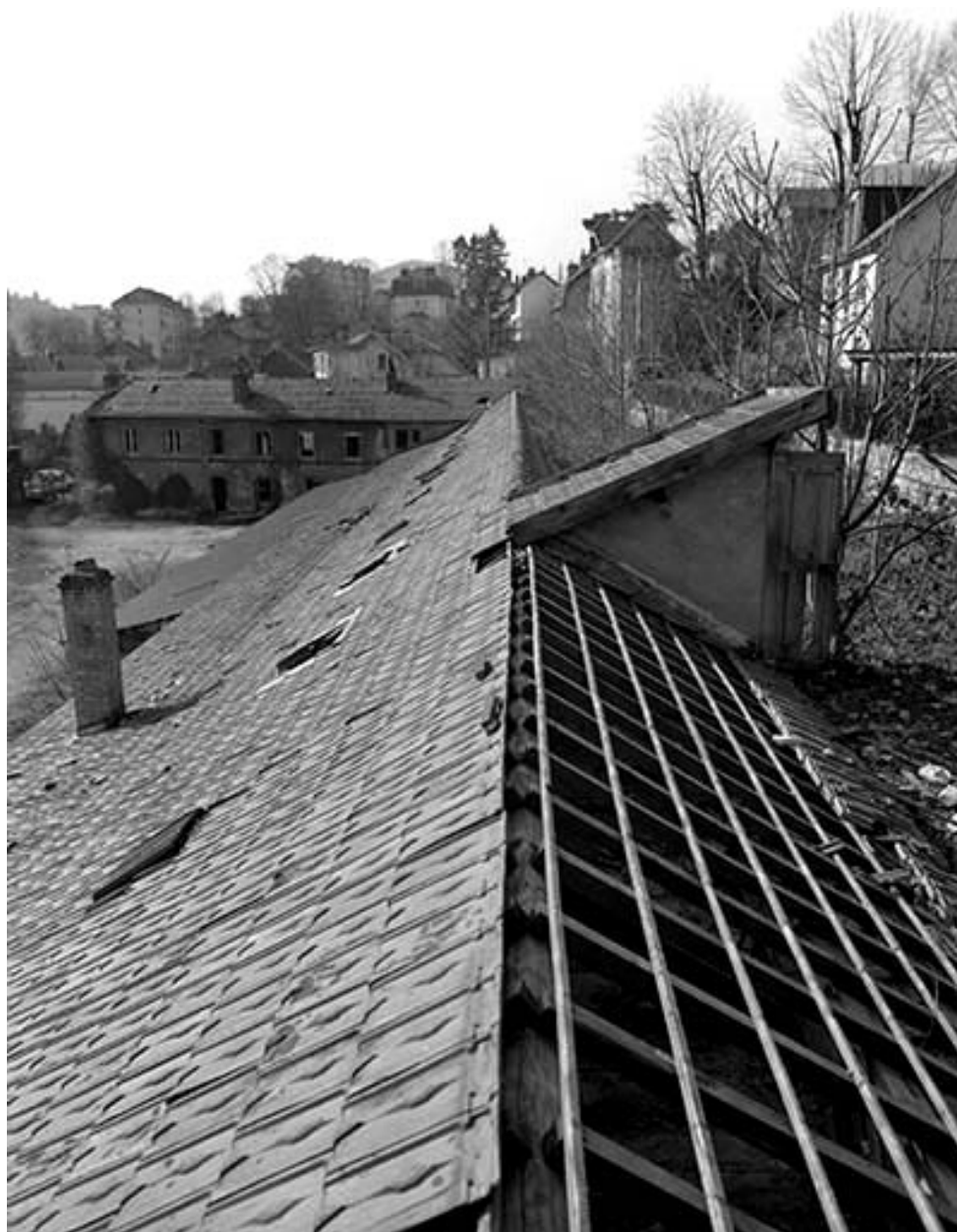
Toiture de la menuiserie.
