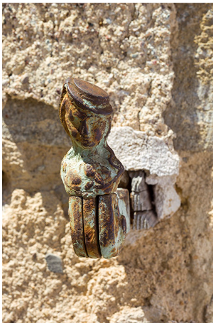
Ferme 5 rue du Château : détail d'un arrêt de volet.
