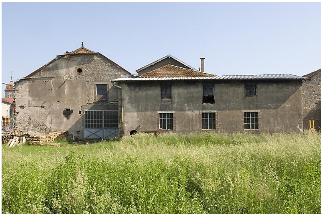
Façades postérieures de la féculerie.
