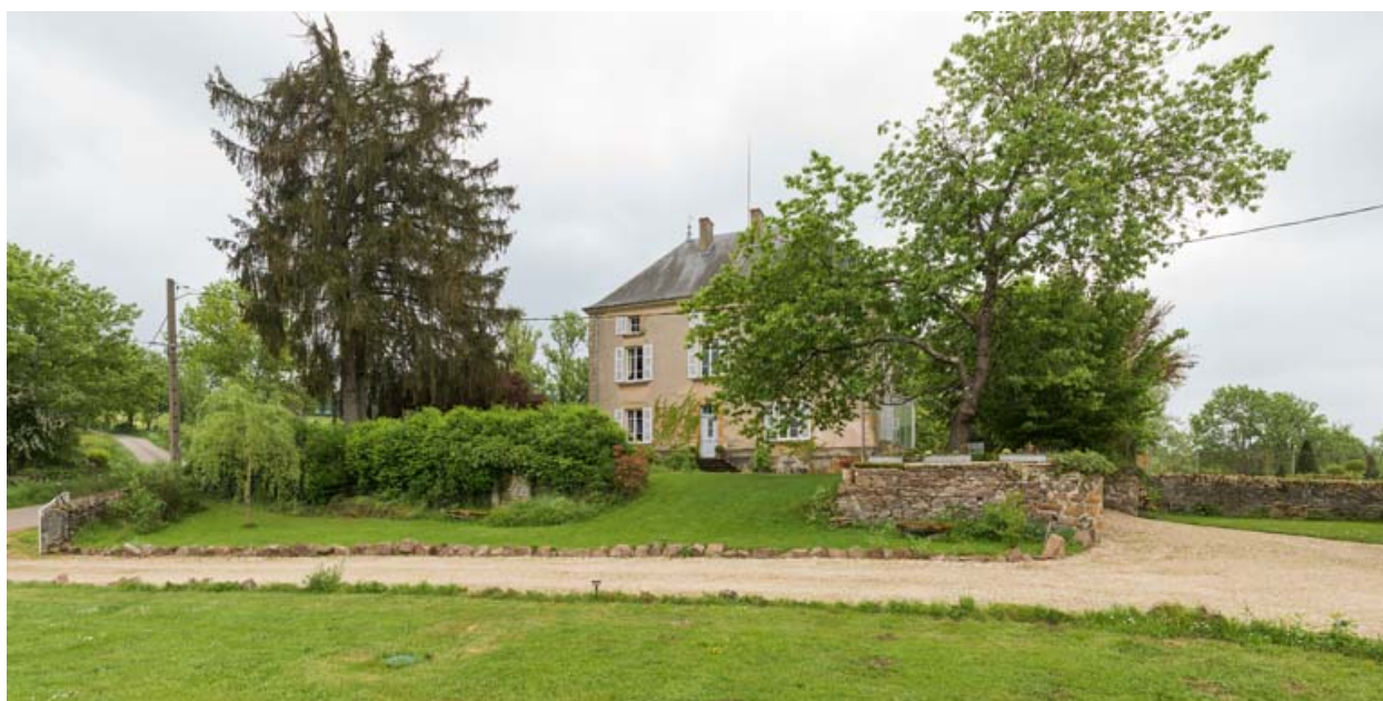
Maison d'habitation. Vue d'ensemble depuis le nord.
