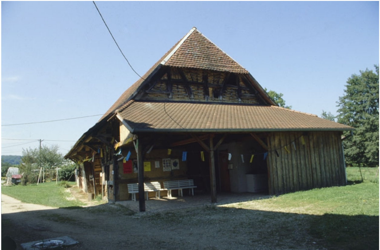
Pignon du bâtiment agricole.
