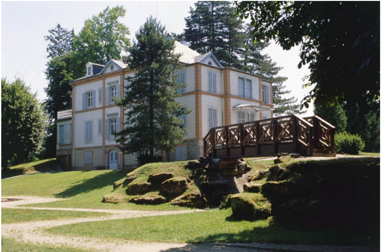
Le logement patronal depuis l'ouest.
