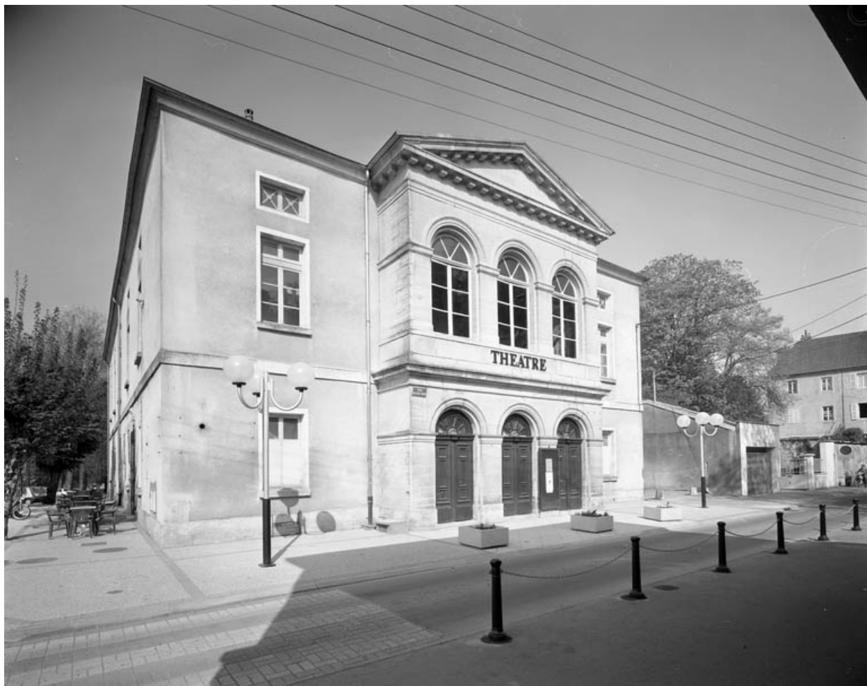
Vue d'ensemble rapprochée.
