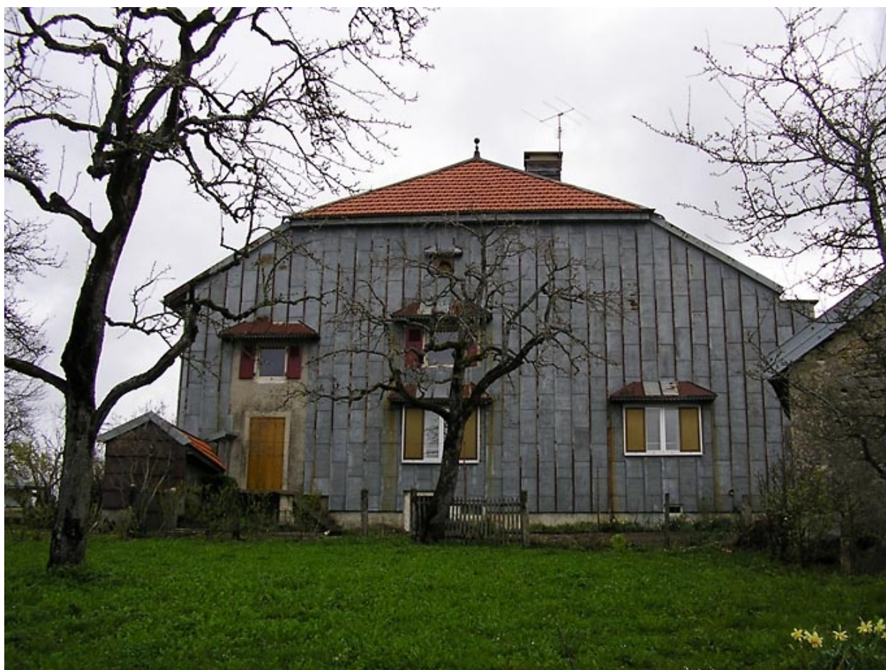
Vue générale du pignon sud-ouest.
