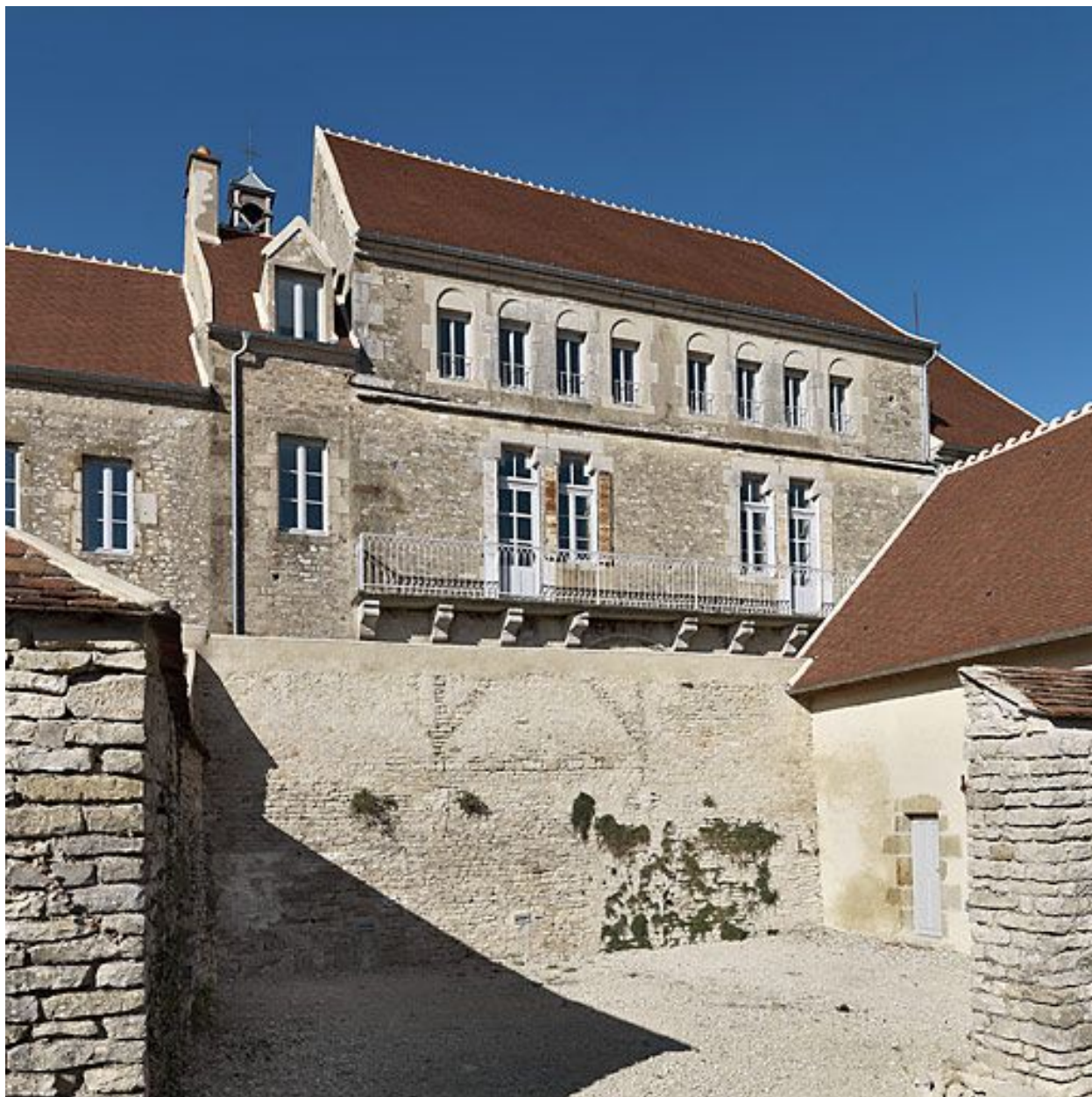
Façade postérieure du corps de bâtiment principal.
