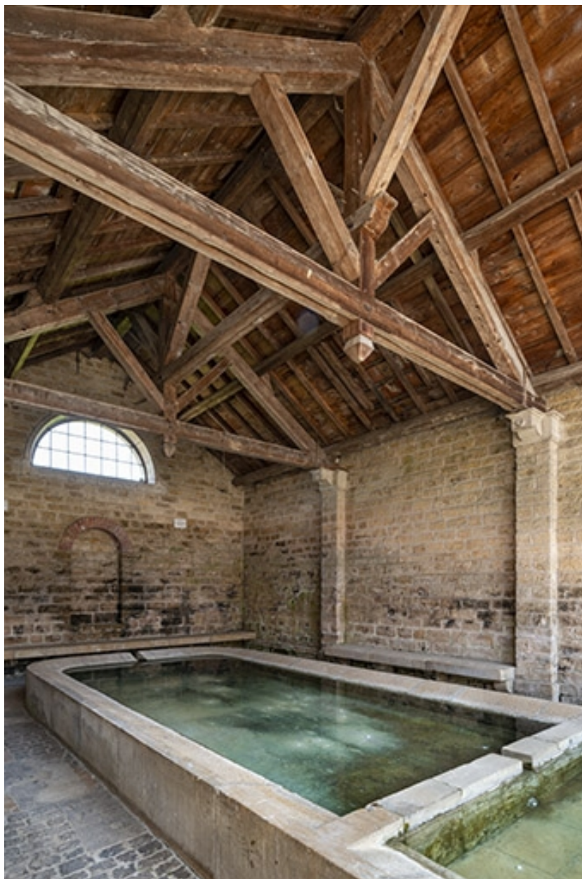
L'intérieur du lavoir, depuis l'entrée.
