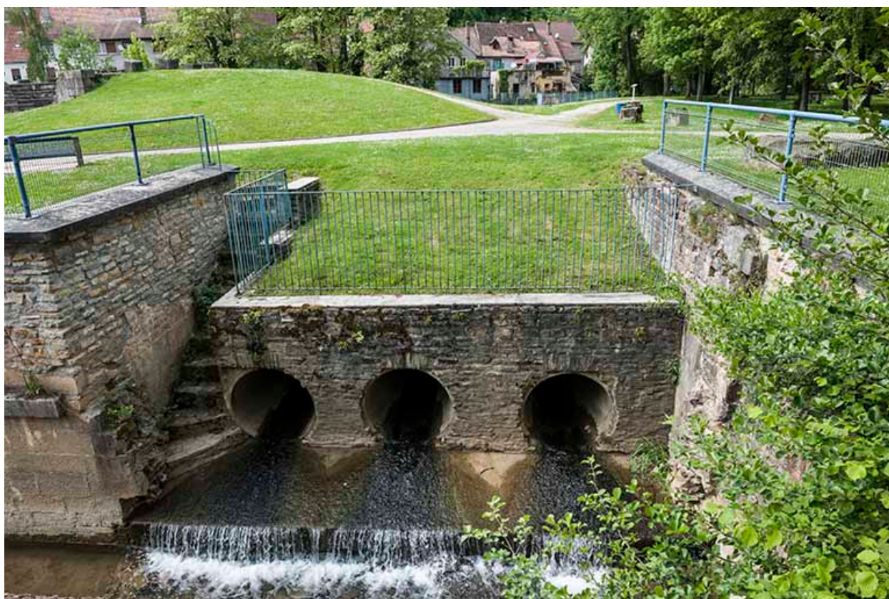
Vestiges des évacuations des turbines hydrauliques.
