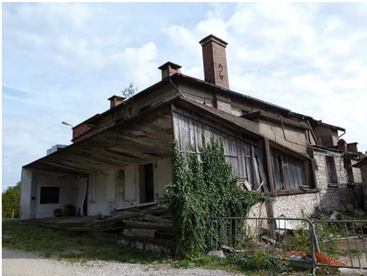
Vue générale nord ouest de la laiterie
