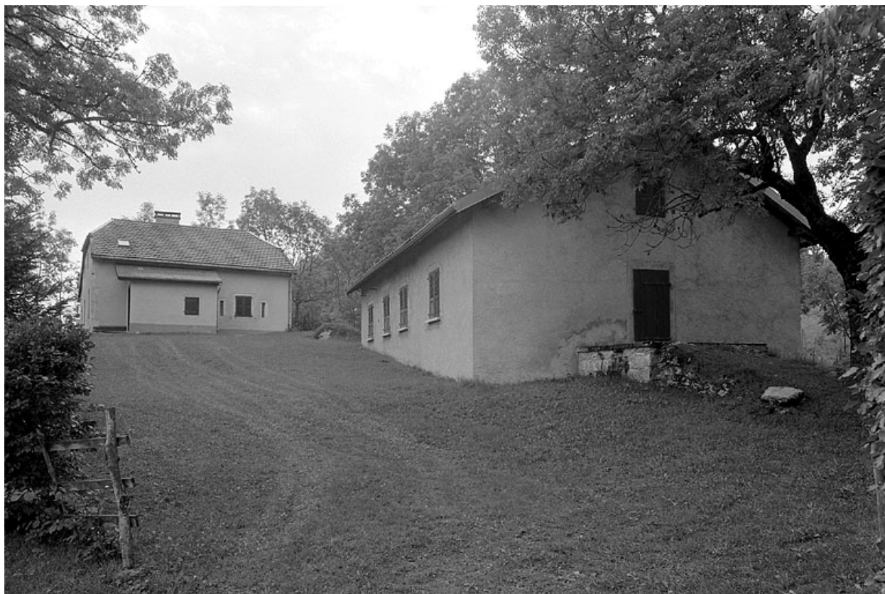
Vue de l'ensemble des bâtiments.
