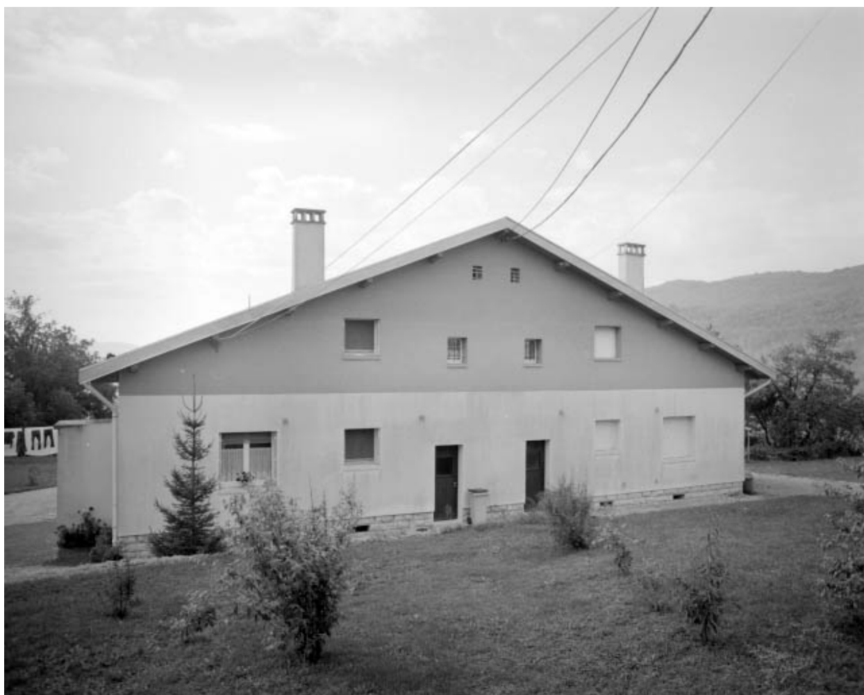
Maison d'agent de maîtrise : façade postérieure.
