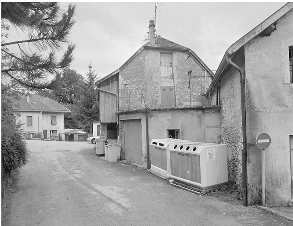
Face droite de l'ancienne fromagerie.
